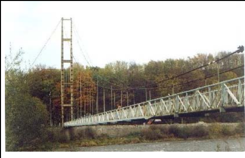
Rys. 15. Kładka w Piwnicznej [12]
