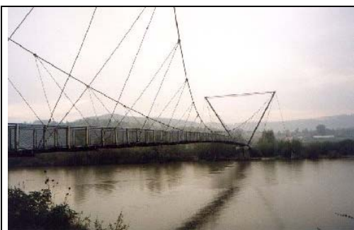
Rys. 18. Kładka w Tropiu [12]
