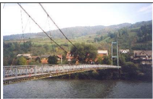
Rys. 19. Kładka w Tylmanowej [12]
